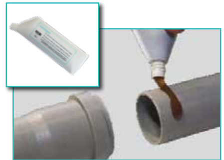
۴ از مایع روان کننده برای جازدن لوله در اتصال استفاده نمایید.
