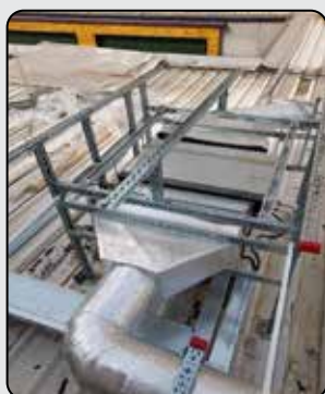
■ نصب داکت اسپیلت در فضای آزاد با اقلام مختلف سوپرفیکس
