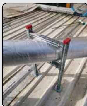
■ مهار کانال هوارسان عایق‌شده به وسیله سوپرفیکس L، پایه و صفحات نصب
