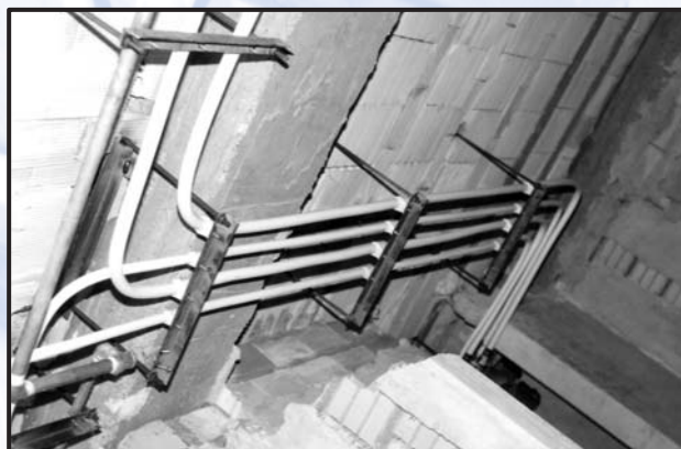
دو نمونه اجرای لوله کشی زیر سقف با استفاده از ساپورت
