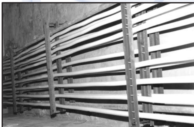
دو نمونه اجرای لوله کشی زیر سقف با استفاده از ساپورت
